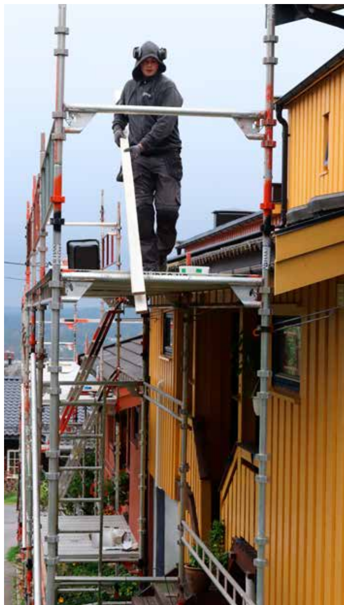
EMMTO Skiftet kledning og malte andre etasje. (Foto: Ove Hansrud)
