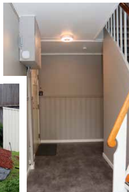
Nytt gulvbelegg, ny maling og nye lamper i oppgangene
