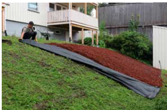
Over: Nye tak og pipebeslag Under: Barklegging av skråningen mellom bygningene
