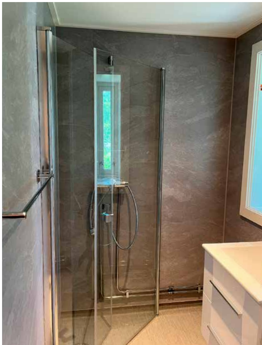
ETTER: Beboerne i Winsnesløkka 13 og 15 har nå fått oppgraderte bad med nye vann- og avløpsrør. Foto: KOBBL
