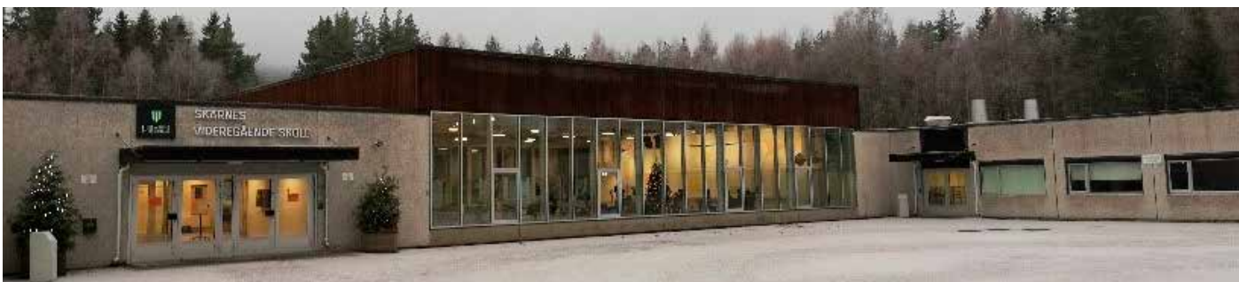
Teknisk rehabilitering av Skarnes VGS.
