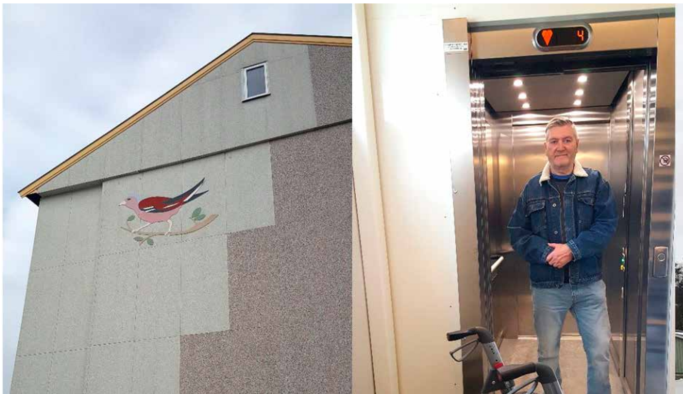
Styreleder i borettslaget, Rune Monsen er godt fornøyd med de nye heisene.
