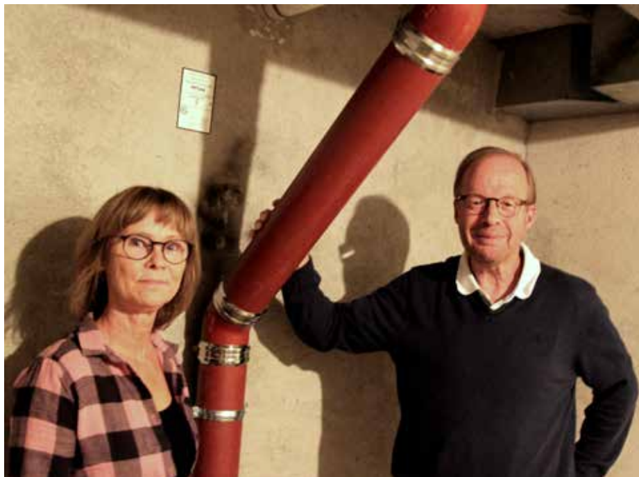
KOSTET MEST: Rehabiliteringen av hele avløpsnett i Winsnesgate brl. tvang seg fram og kom på 2,3 millioner kroner. – Rørsystemet er nå sikret for framtida, opplyser Jorunn Arnesen og Terje Hellerud.
